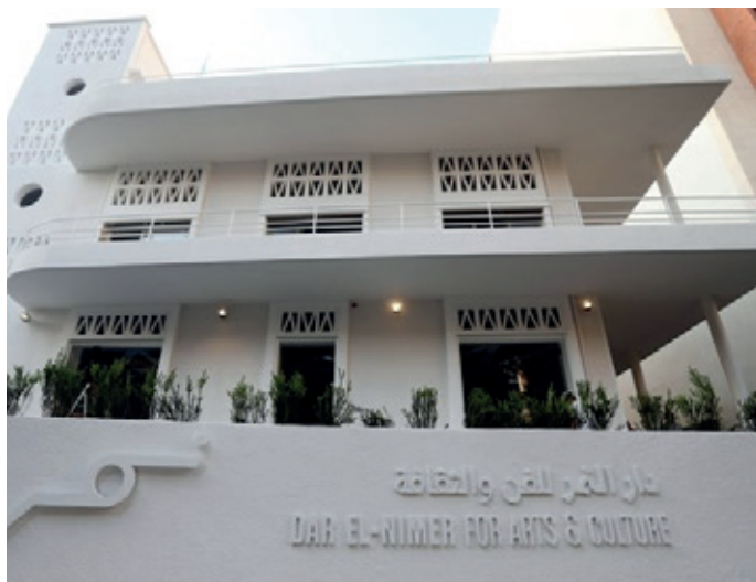
Fondation Dar El-Niemer, Beyrouth, Liban
